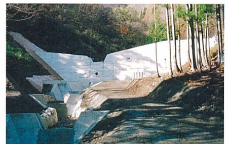
▲対策工後(砂防えん堤)
