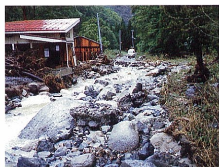
▲人家被災状況(下流部)
