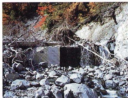
▲砂防えん堤(上流部)
