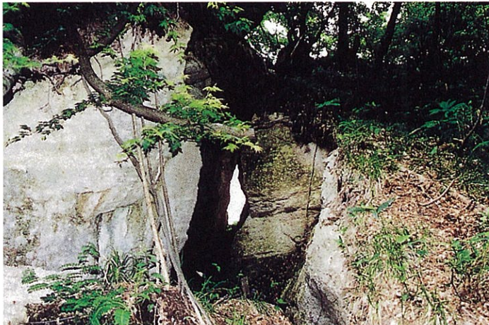
袖の沢地区に発生した亀裂
