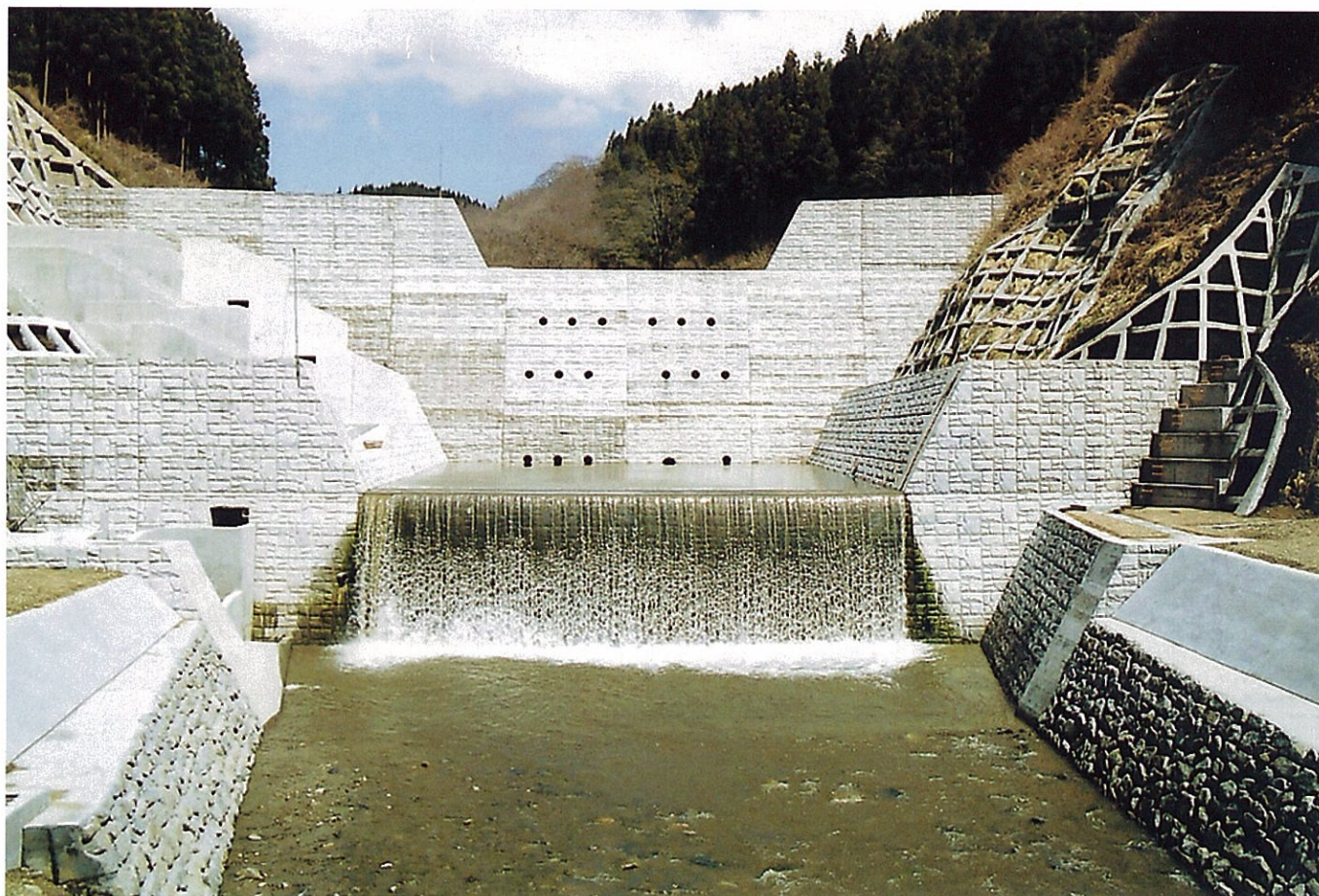
➡ 那倉川砂防えん堤 (塙町)
