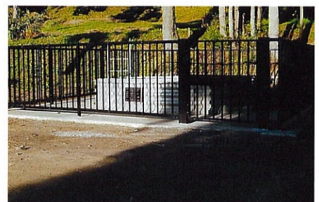
▲対策工後(集水井工)
