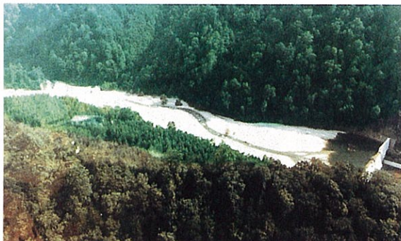
▲長須ヶ玉山砂防えん堤堆砂状況
