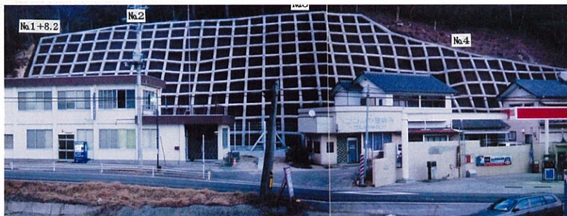
▲対策工後（法枠工）
