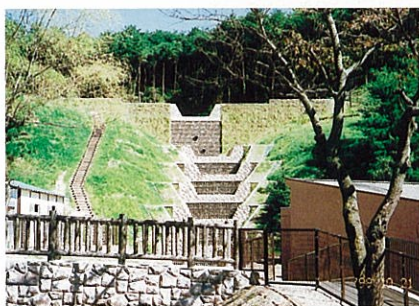
① 完成した砂防えん堤
