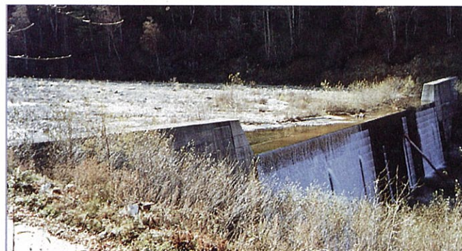
▲長須ヶ玉山砂防えん堤 (現在)
