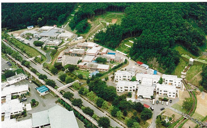
① 対策工後全景
