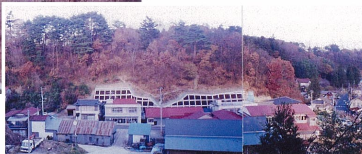
▲対策工後 （法枠工）
