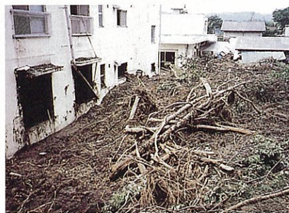
① からまつ荘被災状況 (一部損壊、死者5名・負傷者1名)
