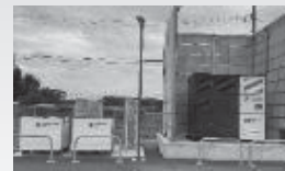
事務所やEV充電器等で 活用予定の水素燃料電池
