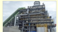
仮設焼却施設
