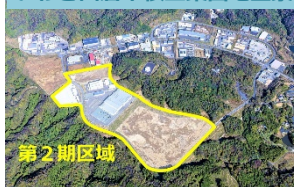
いわき四倉中核工業団地全景
