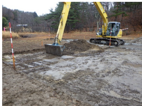
ため池の底質を掘削除去する様子
