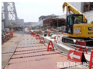
フェーシング前 (3号機付近)
