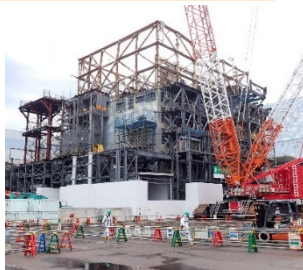
1号機の大型カバー設置の様子
