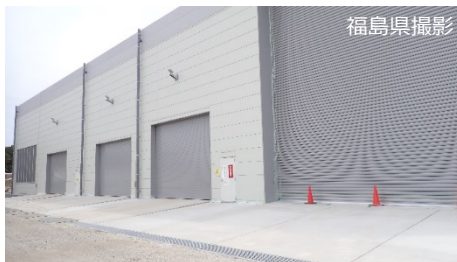
減容処理設備の外観
