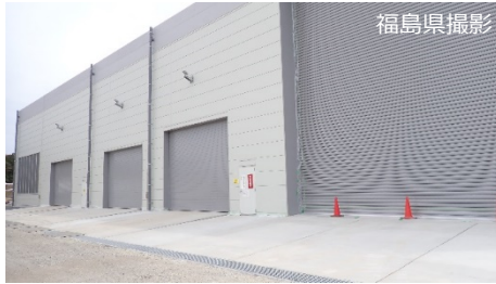
減容処理設備の外観
