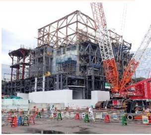
1号機の大型カバー設置の様子
