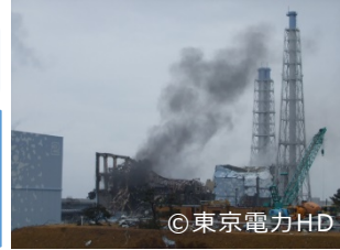
水素爆発を起こした直後の3号機
