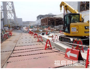
フェーシング前 (3号機付近)
