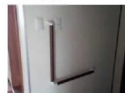
⑦ 玄関へ手すり設置
