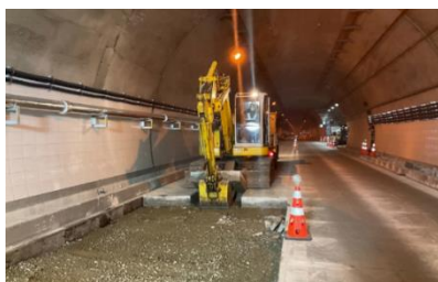
《 路面隆起対策工事 》
