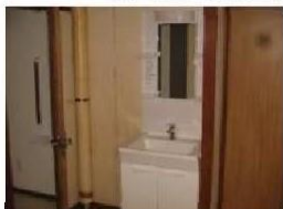
② 洗面所へキャビネット型洗面化粧台設置(シングルバ-混合水栓付き)
