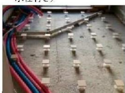
④ ⑤ 浴室・洗面所・台所へ給湯配管設置
