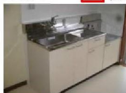
③ 台所の水栓更新(シングルバ-混合水栓付き)
