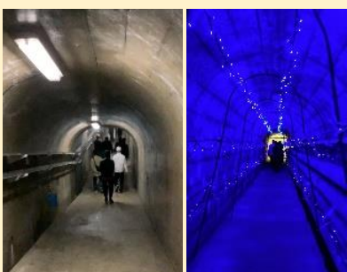
ダム操作室・ダムトンネル
