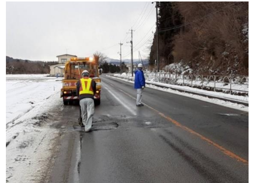
【パトロール（穴埋めの様子）】
