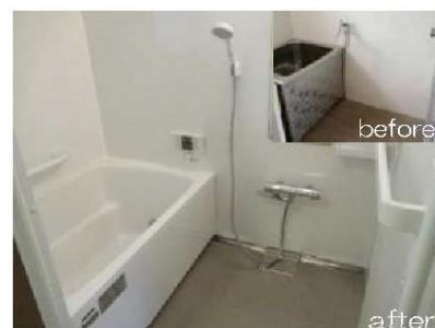
⑥ 浴室へユニットバス(シャ-付き混合水栓付き) ・手すり設置
