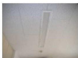
共通(照明のLED化)
