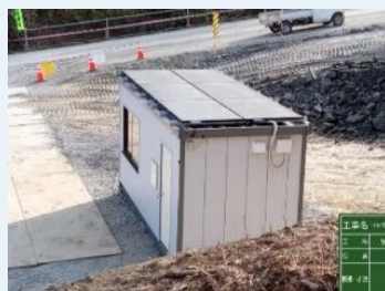
〈工事現場事務所へのソーラーパネル設置〉
