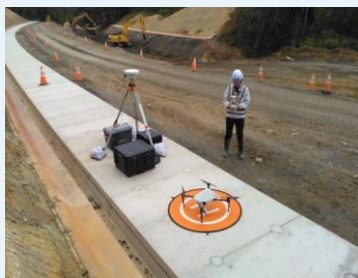
〈ドローンを使用した進捗数量の確認状況〉
