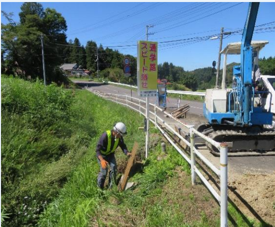
通学路スピード落せ看板設置
