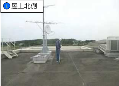
① 屋上北側
