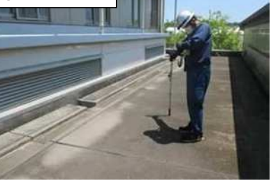
⑰ 屋上南東側
