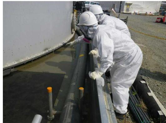
(4/10 堰内の被覆（ウレタン施工）状況)
