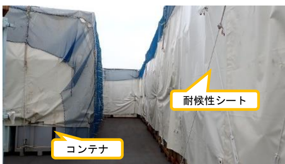
(写真1-1) 一時保管エリアXにおけるコンテナ及びノッチタンクの保管状況①
