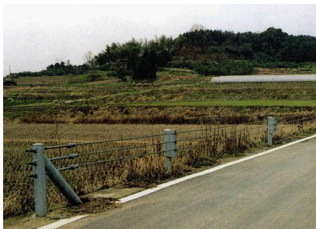
写真-24.3 ガードケーブル設置状況
