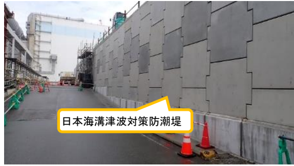
(写真4-2) 防潮堤の状況 (プロセス主建屋東側) (今回撮影)
