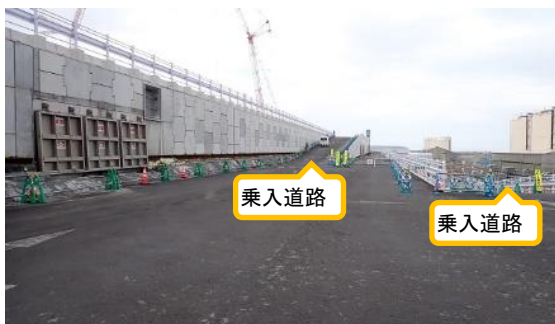
(写真2-2) 乗入道路の状況 (1~3号機タービン建屋東側)
