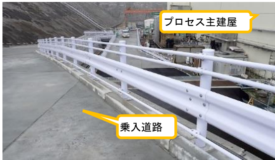
(写真5) 乗入道路の状況 (プロセス主建屋南側)
