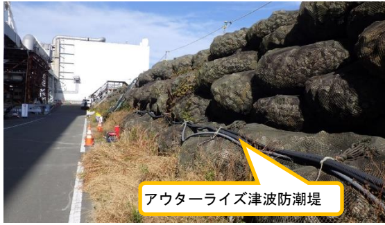
(写真4-1) 防潮堤の状況 (プロセス主建屋東側) (令和4年11月10日撮影)
