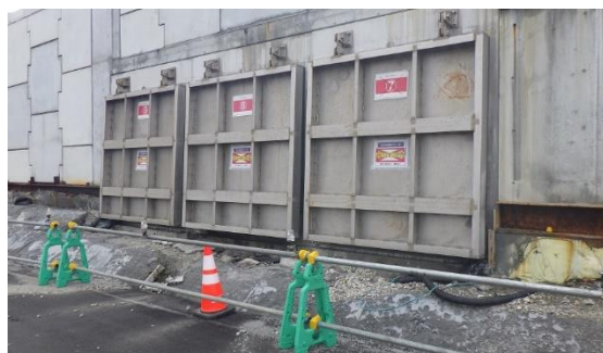
(写真3) フラップゲートの状況
