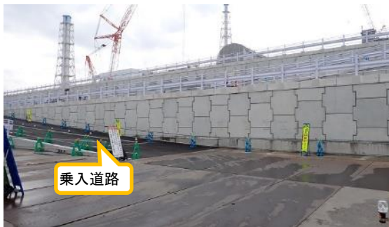
(写真2-1) 乗入道路の状況 (1~3号機タービン建屋東側)
