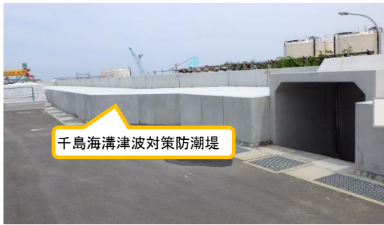
(写真1-3) 防潮堤の状況 (1号機タービン建屋東側) (令和3年6月25日撮影)
