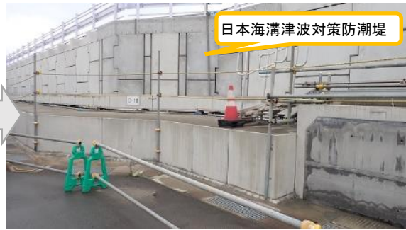
(写真1-4) 防潮堤の状況 (1号機タービン建屋東側) (今回撮影)
