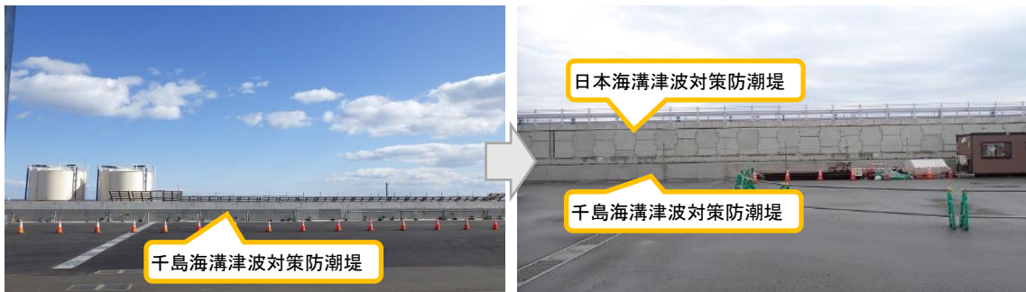
(写真1-1) 防潮堤の状況 (4号機タービン建屋東側) (令和2年2月5日撮影)
