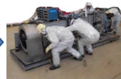
堆積物除去装置 (低圧水) 撤去
