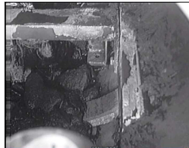
高圧水施工後 ( X-6ペネ右下部 )
