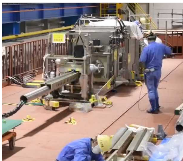
ガイドパイプの挿入
