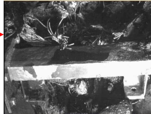
高圧水施工後 ( X-6ペネ中央部 )
