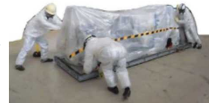
堆積物除去装置 (高圧水、AWJ) 撤去
