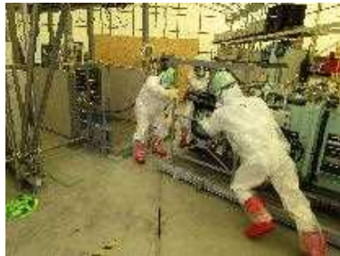
堆積物除去装置 (低圧水) 設置
