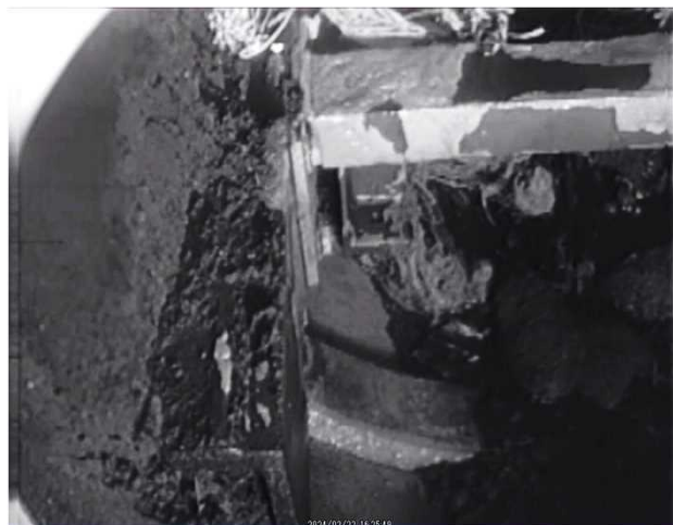
高圧水施工後 ( X-6ペネ左下部 )
