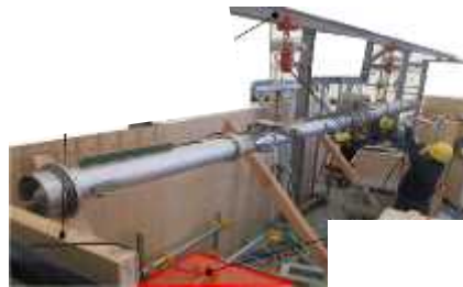
スプレー治具設置 ※X-53ペネに接続
