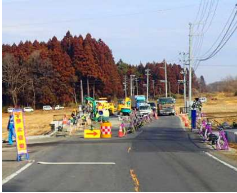
①国道118号(板橋) <整備中>
