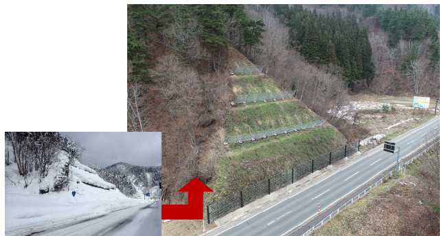
◆国道121号（弥平2工区）＜完成後＞
