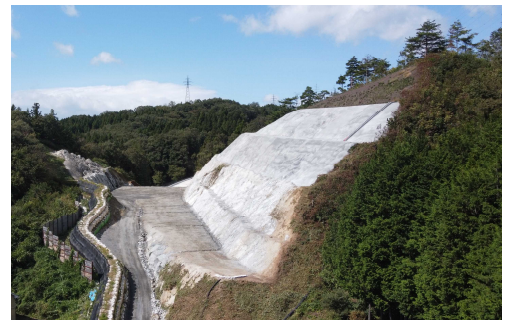
◆いわき石川線(石川BP1工区) <整備中>
