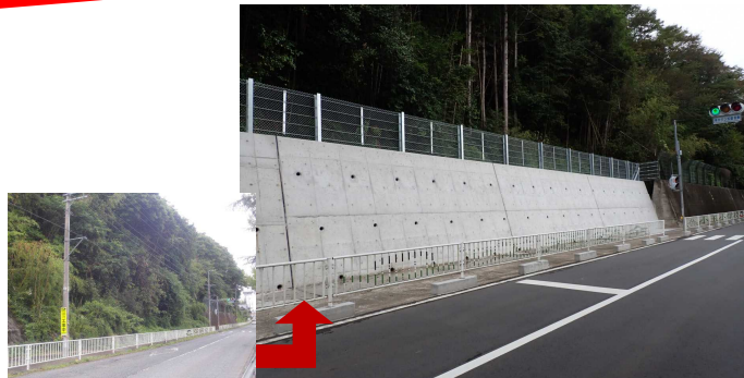
◆小川赤井平線（下野地工区）＜完成後＞
