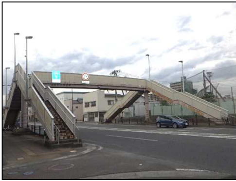
④国道399号（すずかけ横断歩道橋工区）＜整備前＞
