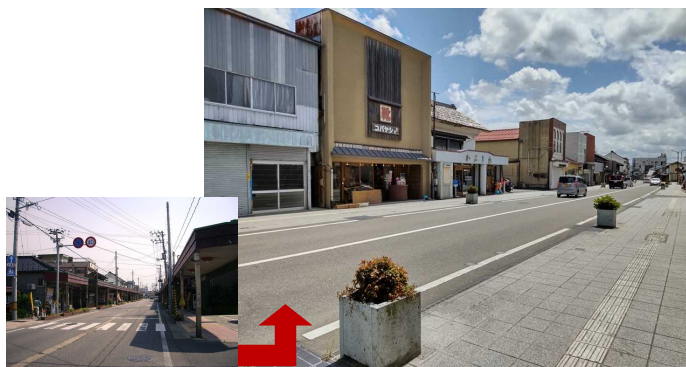
◆喜多方会津坂下線（三丁目工区）＜完成後＞
