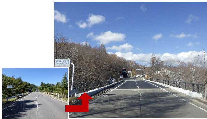
◆国道115号（背戸の沢橋工区）〈完成後〉
