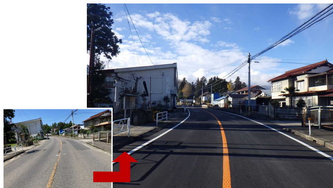
◆郡山湖南線（多田野工区）〈完成後〉
