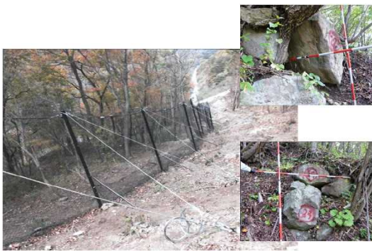
②国道118号(羽鳥) <整備中>
