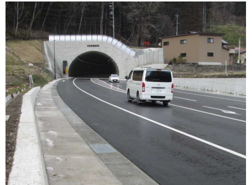
◆国道118号(小沼崎バイパス) <完成後>
