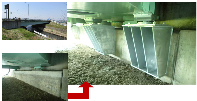
◆国道121号 しんせせなまはし （新潟橋工区）＜完成後＞
