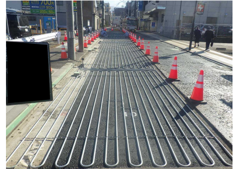
◆国道252号（七日町工区）＜消雪・整備中＞
