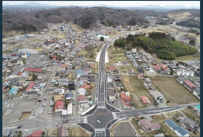
県道本宮三春線 高木工区 令和6年3月16日開通
