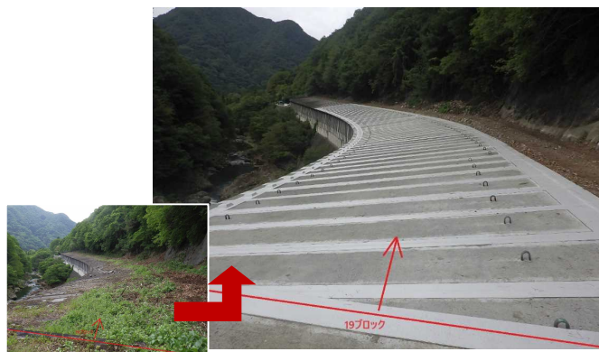
◆国道118号（芦ノ原スノーシェッド工区）〈完成後〉
