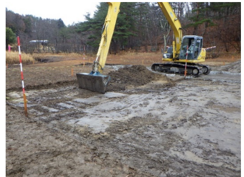
ため池の底質を掘削除去する様子
