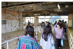
震災遺構浪江町立請戸小学校
