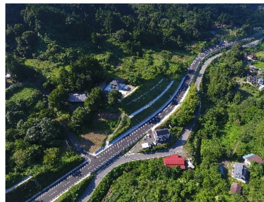
国道349号 (川俣町大綱木工区) 2023年3月21日 完成
