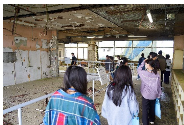
震災遺構浪江町立請戸小学校
