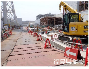
フェーシング前 (3号機付近)
