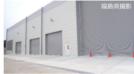
減容処理設備の外観
