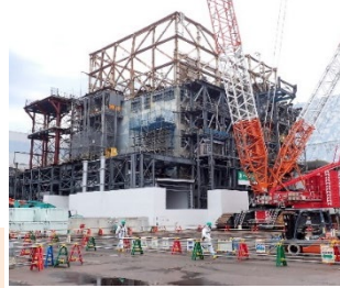
1号機の大型カバー設置の様子
