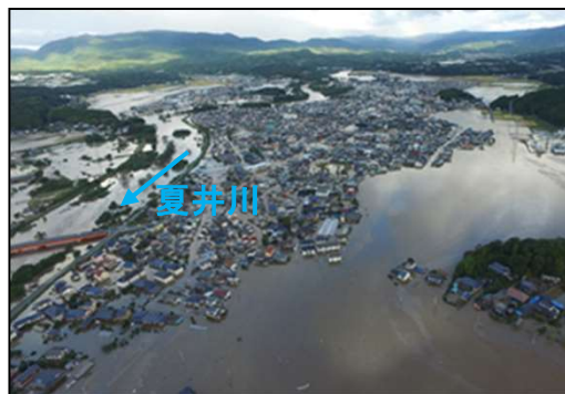
東日本台風による被害状況
