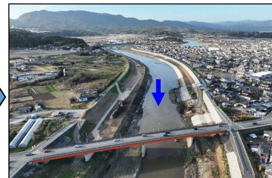
施工中 (R5.12撮影)
