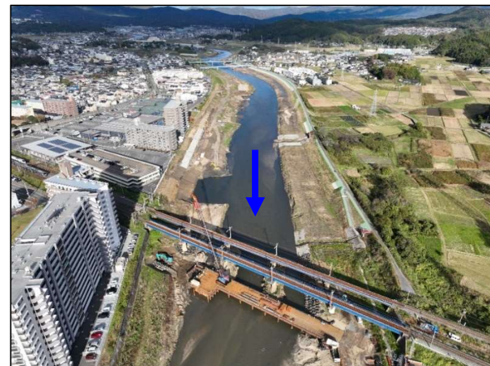
施工中 (R5.11撮影)
