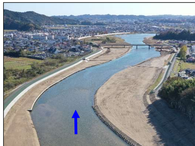
施工中 (R5.11撮影)
