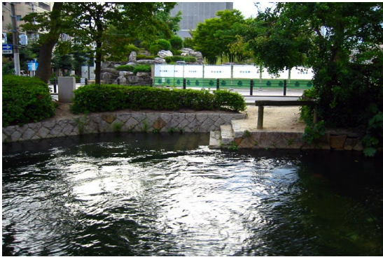
写真-17.11 谷積みを踏襲した護岸、洗い場の再生
