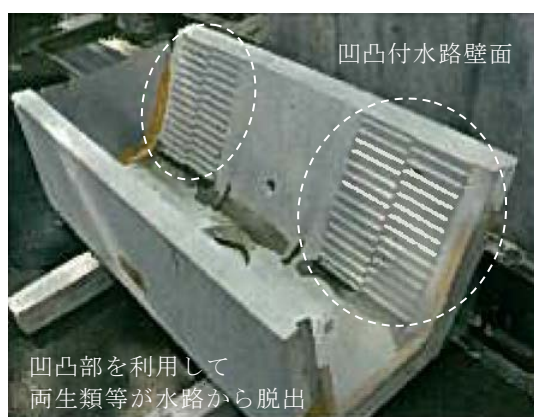
写真-16.1 環境配慮型側溝の事例
