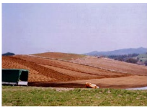
写真-17.6 ファームポンド建設予定地 （事業実施前）
