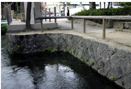
写真-17.9 古くから残る水路護岸の石積み
