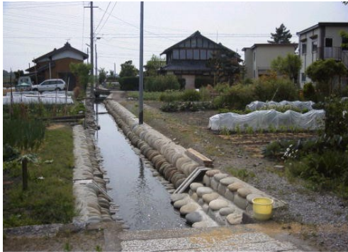
写真-1.3 親水水路に設置された洗い場
