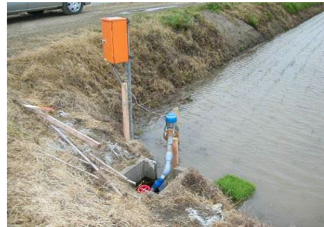
写真-6.4 電磁式積算流量計設置
