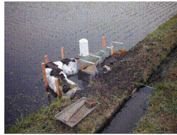
写真-6.2 水口側設置例
