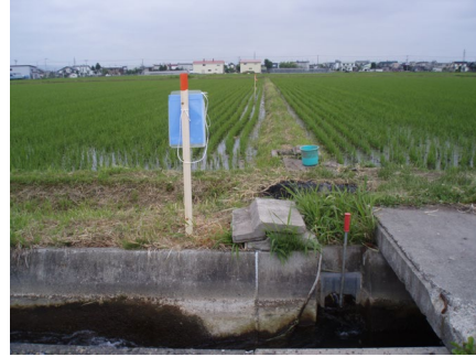
写真-6.12 水管理野帳設置状況
