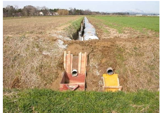
写真-6.8 流末側の三角堰設置例
