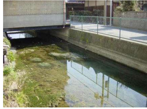
写真-9.2 水路の状況
