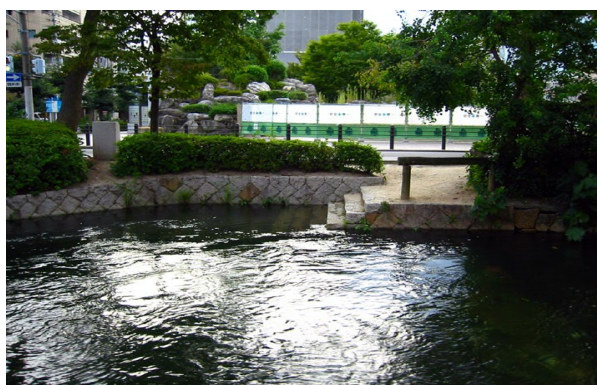
写真-15.12 谷積みを踏襲した護岸、洗い場の再生
