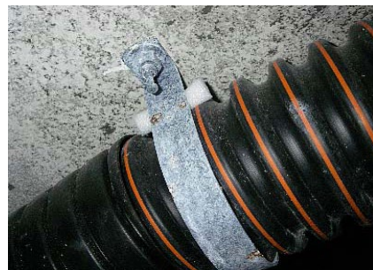
写真-14.13 シーリング材による対応
