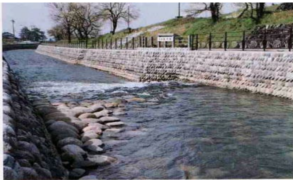
写真-15.8 事業実施後 - 水利遺構（堤）の保全
