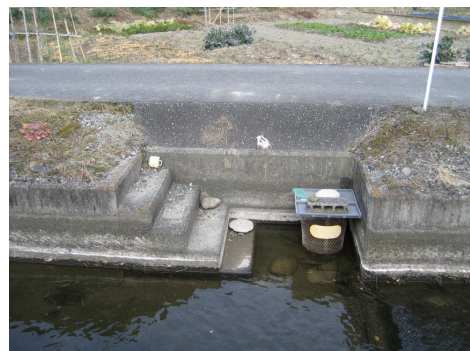
写真-1.2 用水路に設置された洗い場
