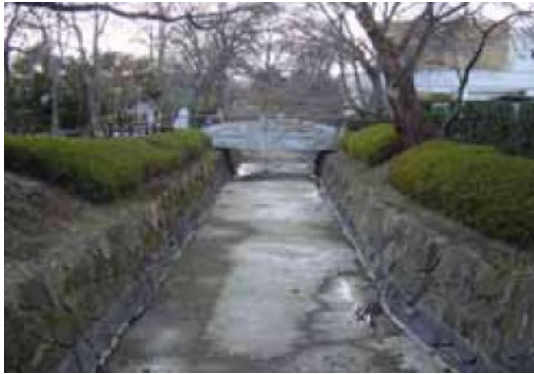
写真-16.2 導入前の状況
