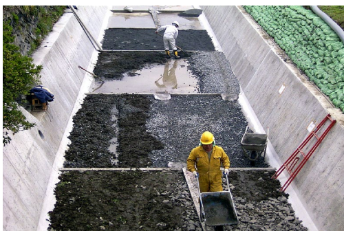
写真-14.4 施工状況
