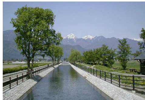
写真-3.3 改修工事後
