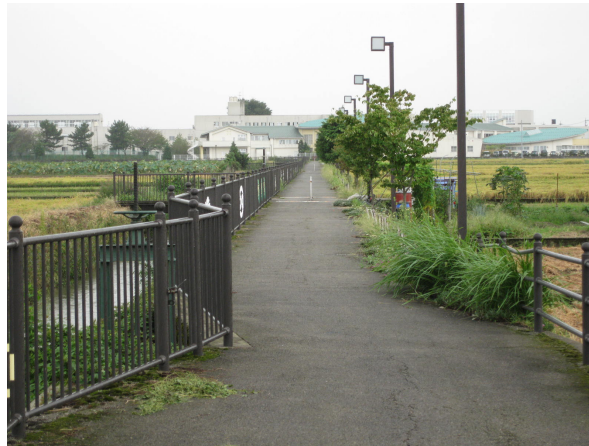
写真-22.5 水路脇にある街灯（発電した電気を供給）
