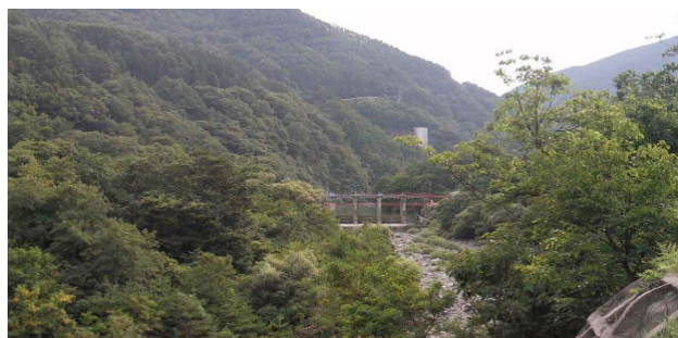
写真-15.3 事業実施前の頭首工（遠景）
