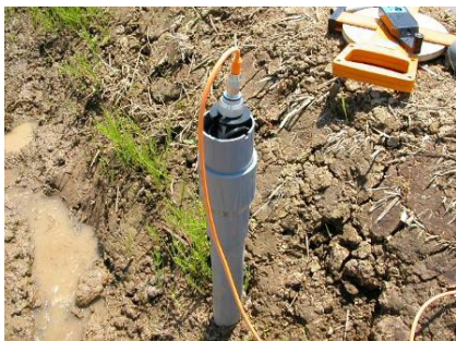
写真-6.9 水位センサー式水位計設置例1
