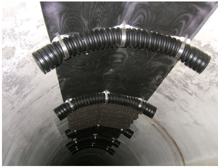
写真-14.9 設置後のコウモリピット
