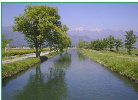
写真-3.2 改修工事前
