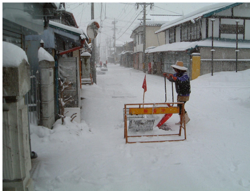
写真-1.7 用水路を利用した消流雪溝
