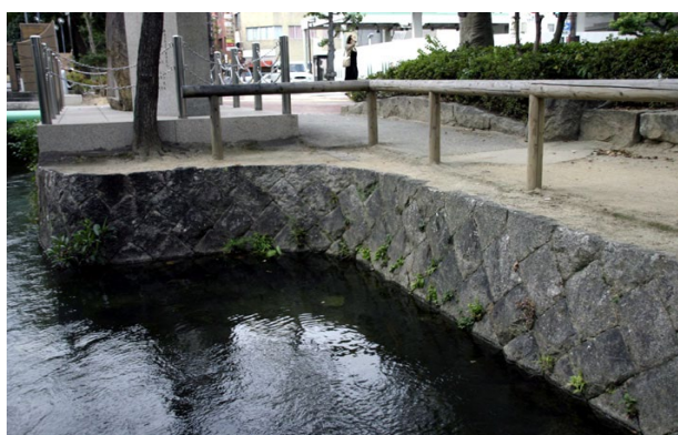
写真-15.10 古くから残る水路護岸の石積み
