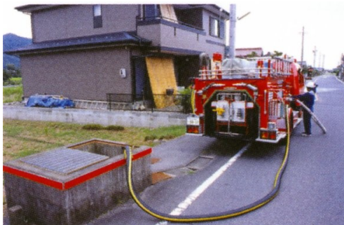
写真-1.5 道路下の暗渠脇にある防火水槽
