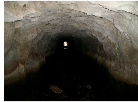
写真-14.7 改修前のトンネル
