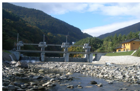
写真-15.5 事業実施後（近景）
