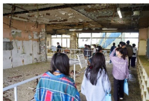
震災遺構浪江町立請戸小学校
