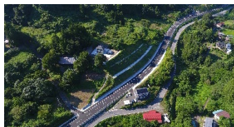
国道349号(川俣町大綱木工区) 2023年3月21日 完成
