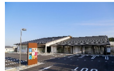
大熊町：商業施設
