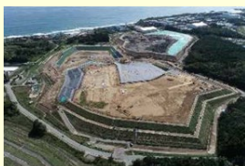
中間貯蔵施設の様子
