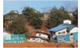
家屋被害：福島市
