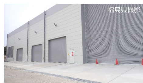
減容処理設備の外観
