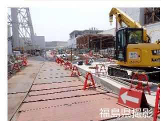
フェーシング前 (3号機付近)
