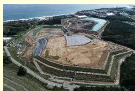
中間貯蔵施設の様子
