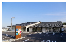
大熊町：商業施設
