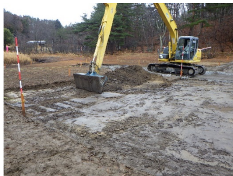
ため池の底質を掘削除去する様子
