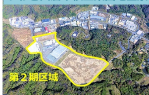
いわき四倉中核工業団地全景
