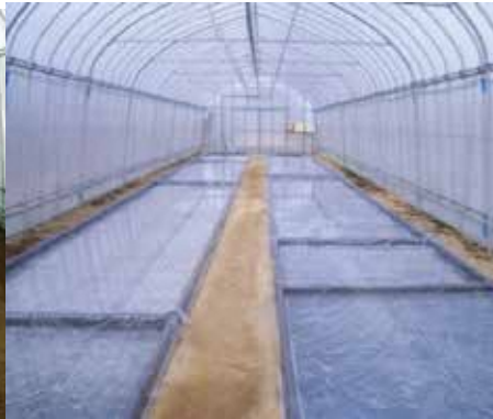
図Ⅲ-20 プール枠設置
