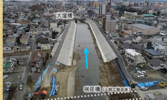
② 大窪橋から咲田橋までの区間 【令和6年3月撮影】
