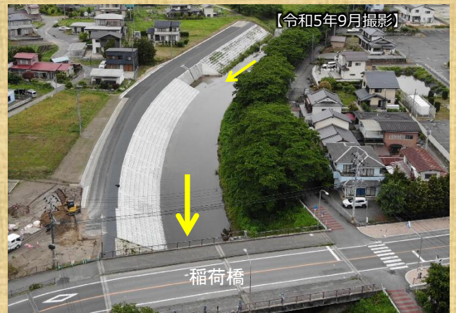
稲荷橋上流護岸 工事状況
