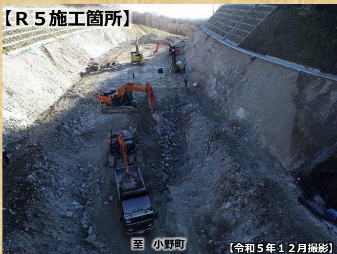
【施工状況（岩の掘削工事）】
