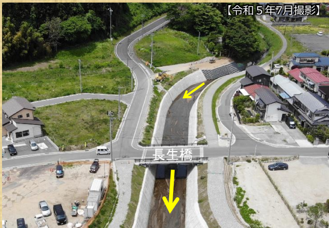
車川護岸 工事状況
