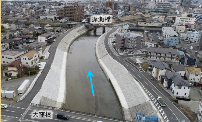
① 逢瀬橋から大窪橋までの区間 【令和6年3月撮影】
