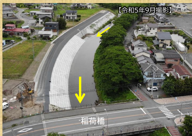
稲荷橋上流護岸 工事状況
