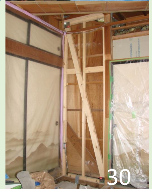
耐震改修の状況
