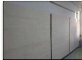
図2 三台の作業板
