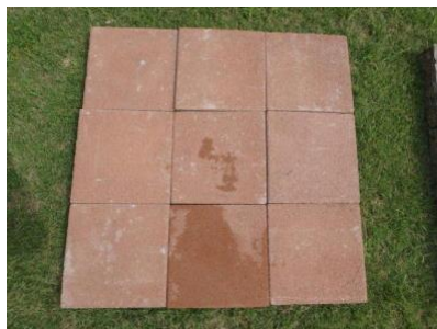
図-1 透水平板設置状況
