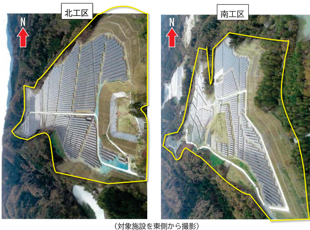
参考：航空写真（設置後） 相馬市坪田字大沢口地内
