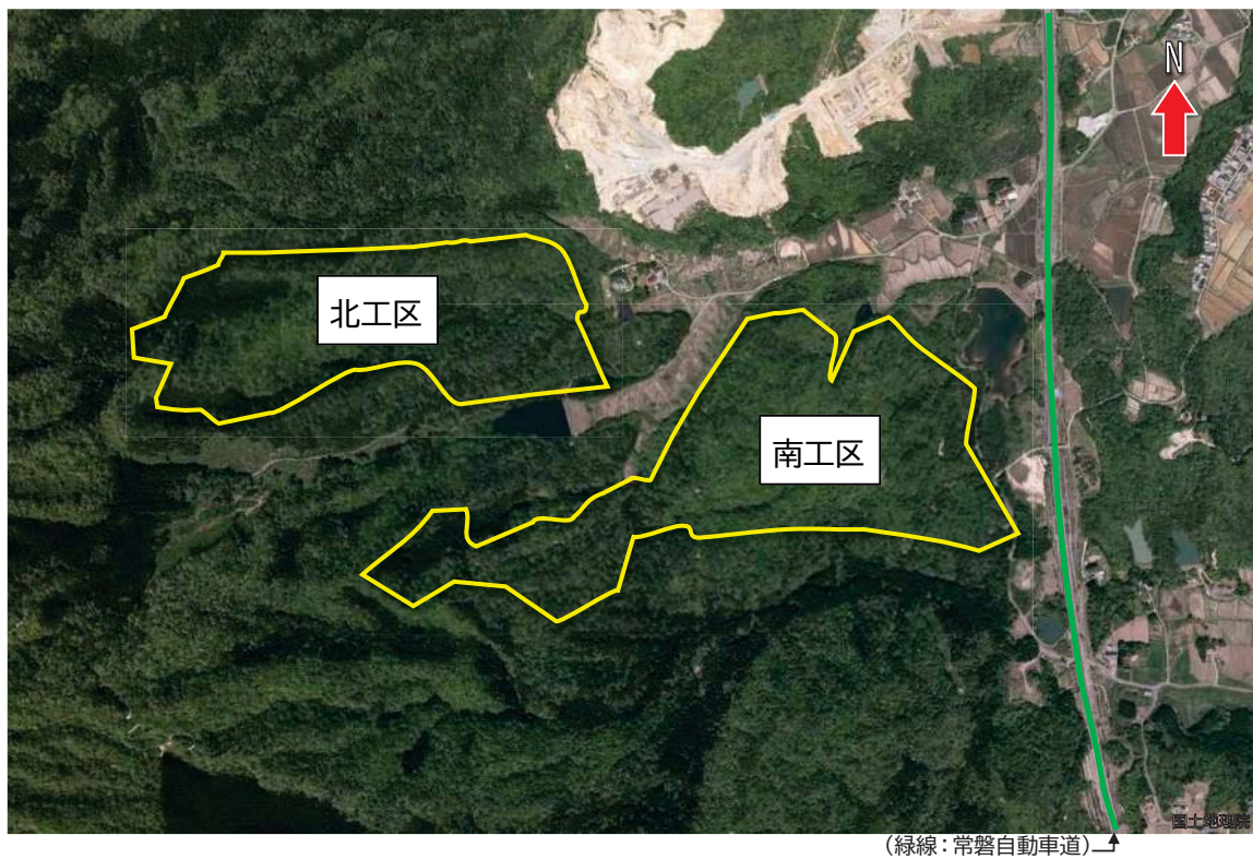
参考：航空写真（設置前） 相馬市坪田字大沢口地内
