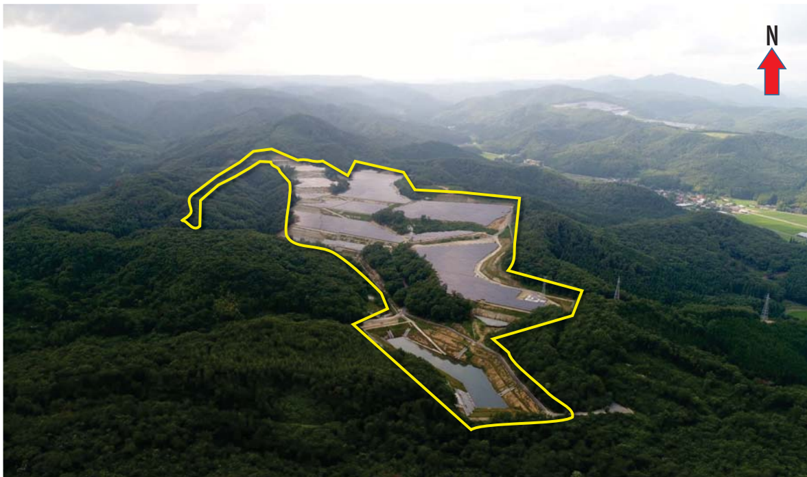
参考：航空写真（設置後） 西郷村羽太字大沢地内
