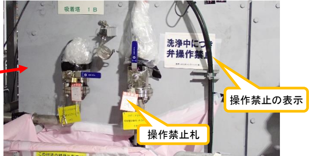
(写真4-2) 仮設ホース接続部の弁付近の状況② (南側から撮影)
