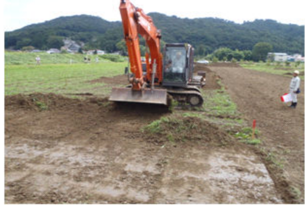
レーザーバックホウによる表土の削り取り
