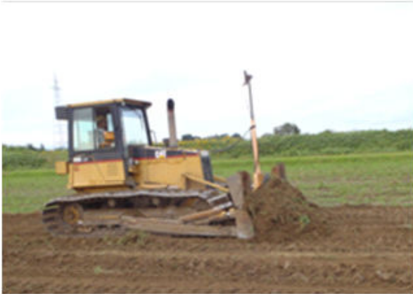
レーザーブルによる表土の削り取り
