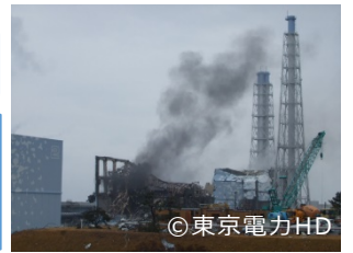
水素爆発を起こした直後の3号機
