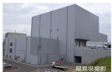
増設雑固体廃棄物焼却設備
