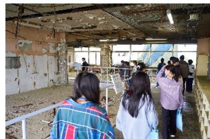
震災遺構浪江町立請戸小学校
