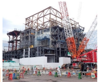
1号機の大型カバー設置の様子
