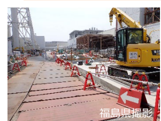
フェーシング前 (3号機付近)
