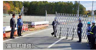
(富岡町提供) 避難指示解除にあわせ、道路に設置されていたバリケードが撤去されました。
