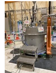
安定化工程設備 (3設備のうちの1設備)
