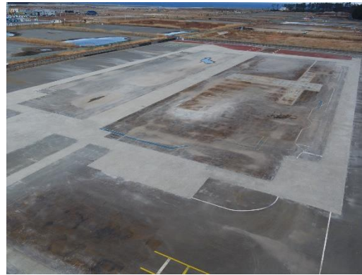
受入・分別施設 (22年11月 解体完了)
