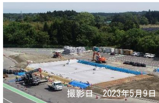
浸透水処理工（盛土底盤部）
