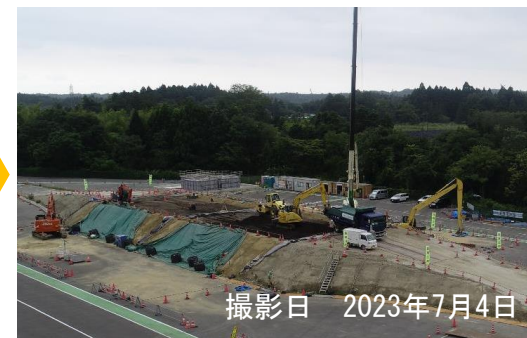
路体盛土工（路体11層目）
