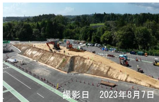
路床盛土工（覆土）
