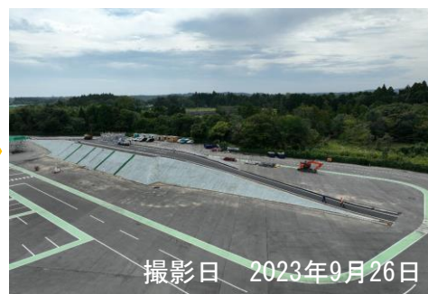
路面排水・舗装・法面工
