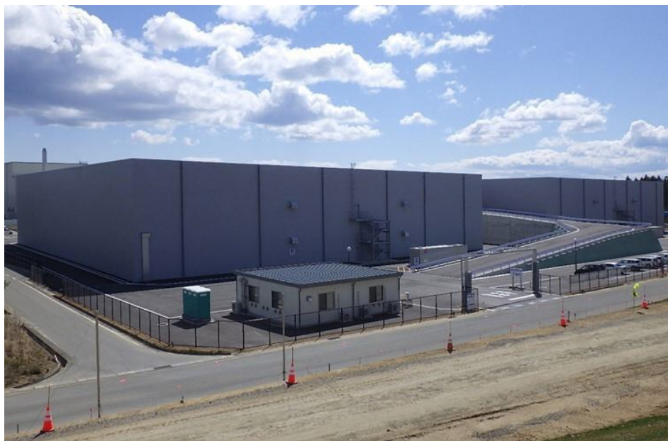
廃棄物貯蔵施設の外観
