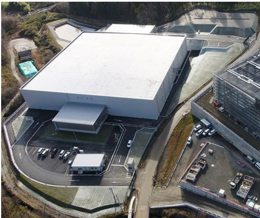
廃棄物貯蔵施設の外観
