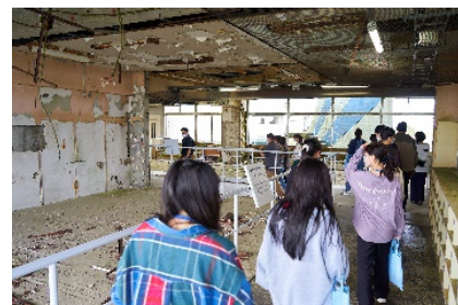
震災遺構浪江町立請戸小学校
