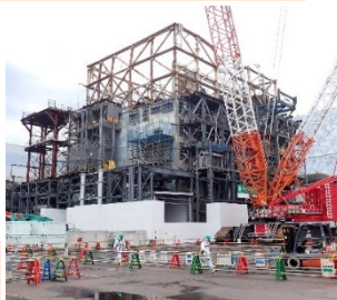
1号機の大型カバー設置の様子
