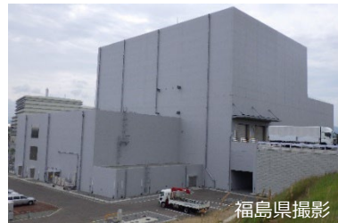
増設雑固体廃棄物焼却設備
