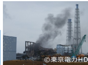
水素爆発を起こした直後の3号機
