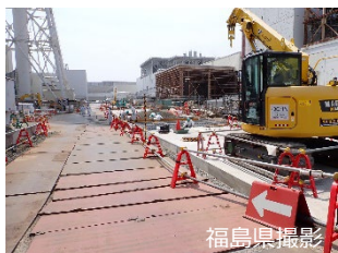
フェーシング前 （3号機付近）
