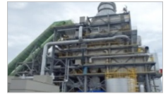
仮設焼却施設
