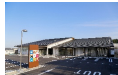
大熊町：商業施設
