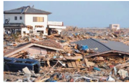
津波被害：浪江町
