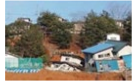
家屋被害：福島市
