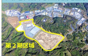
いわき四倉中核工業団地全景
