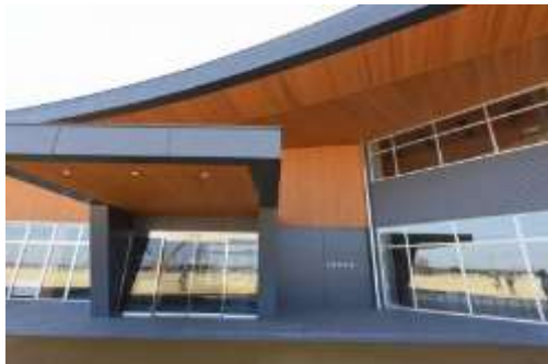
大熊町役場本庁舎 【出典】大熊町
