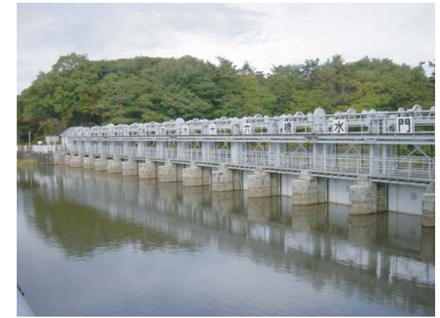
写真：十六橋水門
