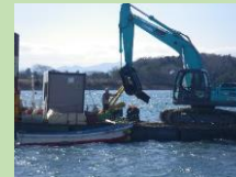
漁場内のがれき等の除去作業
