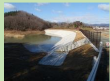
老朽化したため池の改修
