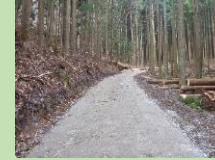
森林作業道の開設
