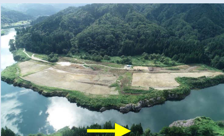
施工中 (令和5年9月末時点)
