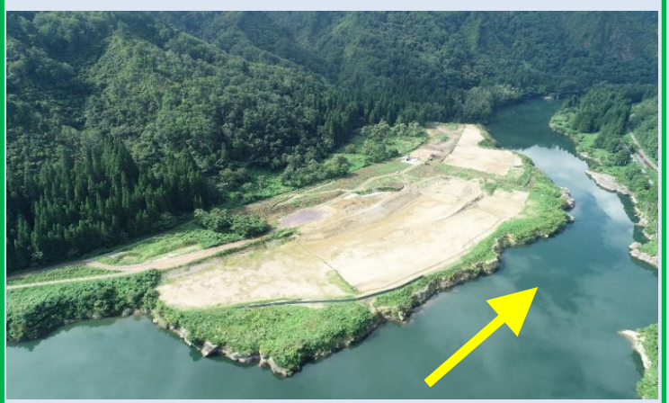
施工中 (令和5年9月末時点)
