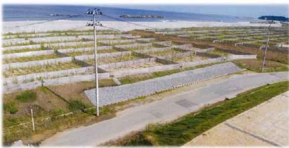
ドレーン工法による盛土法面の復旧状況 (浪江町)
