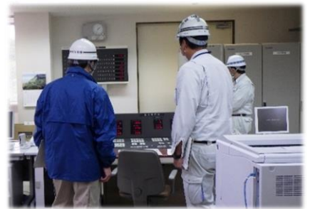
合同診断の様子 (松ヶ房ダム 相馬市)
