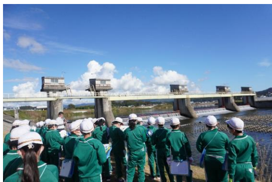
▲ 愛谷堰頭首工
