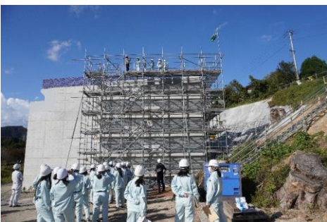
▲ U型擁壁工(広域農道いわき地区)
