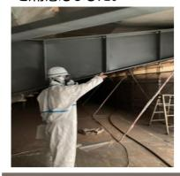
塗装の厚み が適切かどうか 検査をしていま す。人体に有 害な塗料のた め、ガスマスク を着用していま す。
