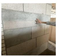
劣化部分を除去し、新たに断面修復材にて、コンクリート断面を復元しています。規定通りに修復しているか、長さを測りました。
