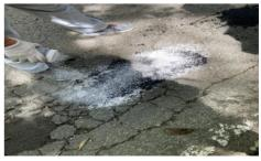
上の写真は、常温合材と 石灰を用いて舗装路面の 穴ぼこ修理を行なっていると ころです。交通量の多い道 路や重いトラック等が通ることで、道路の劣化が進むそ うです。
