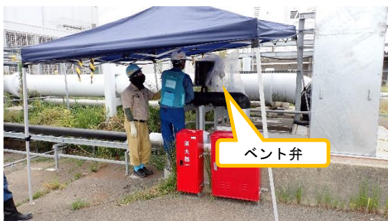
(写真2) ベント弁カバー内部確認の状況
