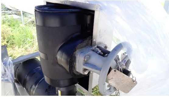
(写真3) ベント弁カバー内部の状況
