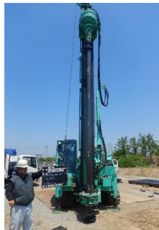
aウイングパイル工法による地中熱交換器設置
