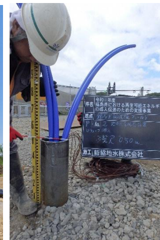
aウイングパイル工法による地中熱交換器設置
