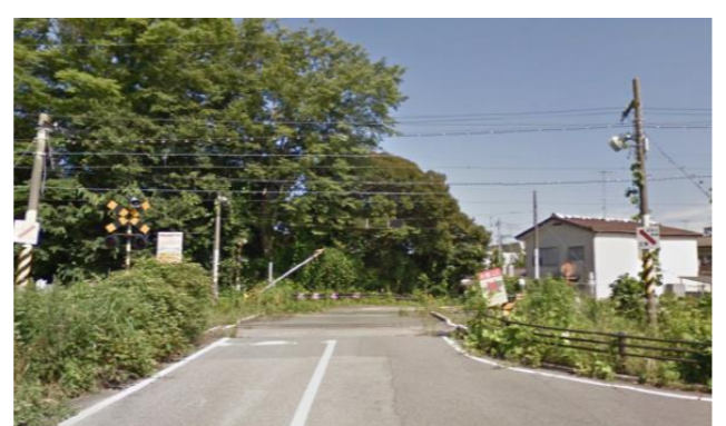
【写真② JR跨線橋区間の状況】
