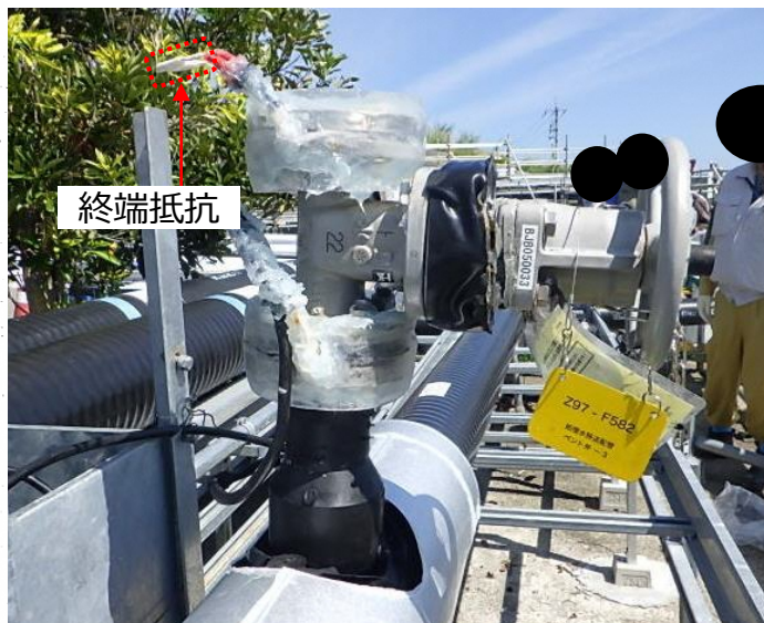
ゲルパッキング施工状況
