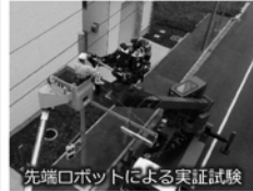
先端ロボットによる実証試験
